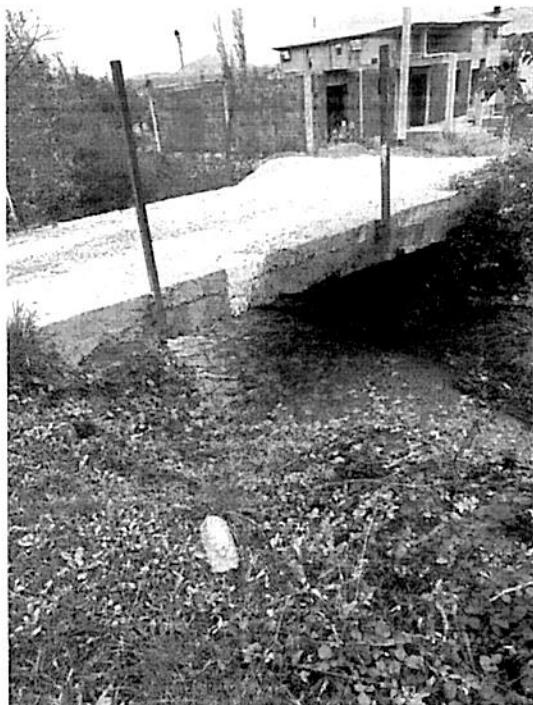
Propust u Ulici 15 je improvizovani prelaz napravljen od dva čelična profila koji nose drvene pragove, preko kojih je izlivena tanka betonska ploča debljine 8-10 cm. Potporni zid u potoku je u dobrom stanju, bez znakova podlokavanja. Dimenzije propusta u osnovi su 3,0 x 3,0 metra, a ograda ne postoji.
