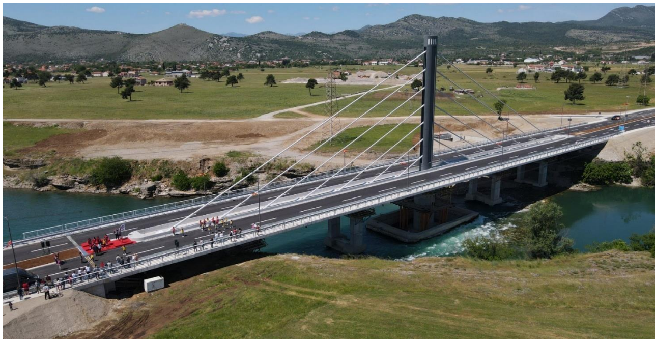
Slika br.1.11. Most “Luča” na jugozapadnoj obilaznici koja povezuje magistralne pravce koji povezuju Glavni grad sa Cetinjem i Petrovcem
