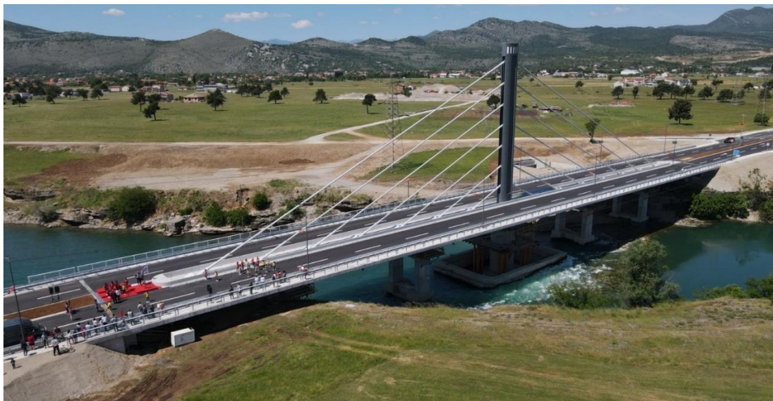
Slika br.1.11. Most “Luča” na jugozapadnoj obilaznici koja povezuje magistralne pravce koji povezuju Glavni grad sa Cetinjem i Petrovcem
