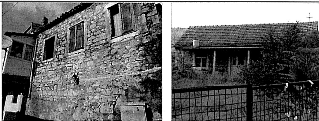
Slika br.2.16a. Primjeri gradnje zidanih objekata tesanim kamenom u opštini Podgorica (NERA, 2014).
