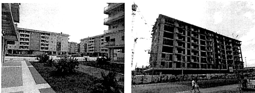
Slika br.2.16c. Primjer zidanih stambenih objekata sa AB ojačanjem (lijevo) i objekata sa ramom od prenapregnutog betona – izgrađenih prije 1981. godine (desno) (NERA, 2014).
