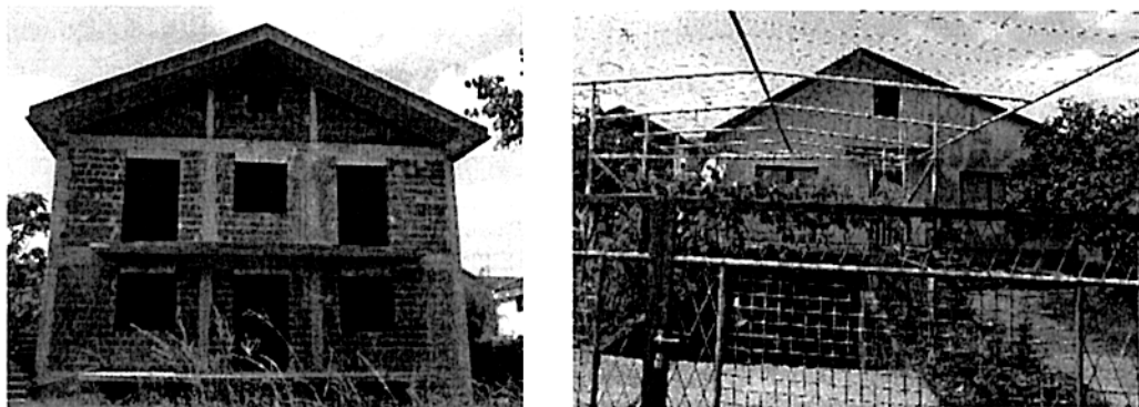
Slika br.2.16b. Primjeri zidanih objekata sa betonskim podovima na teritoriji Glavnog grada Podgorica (NERA, 2014).
