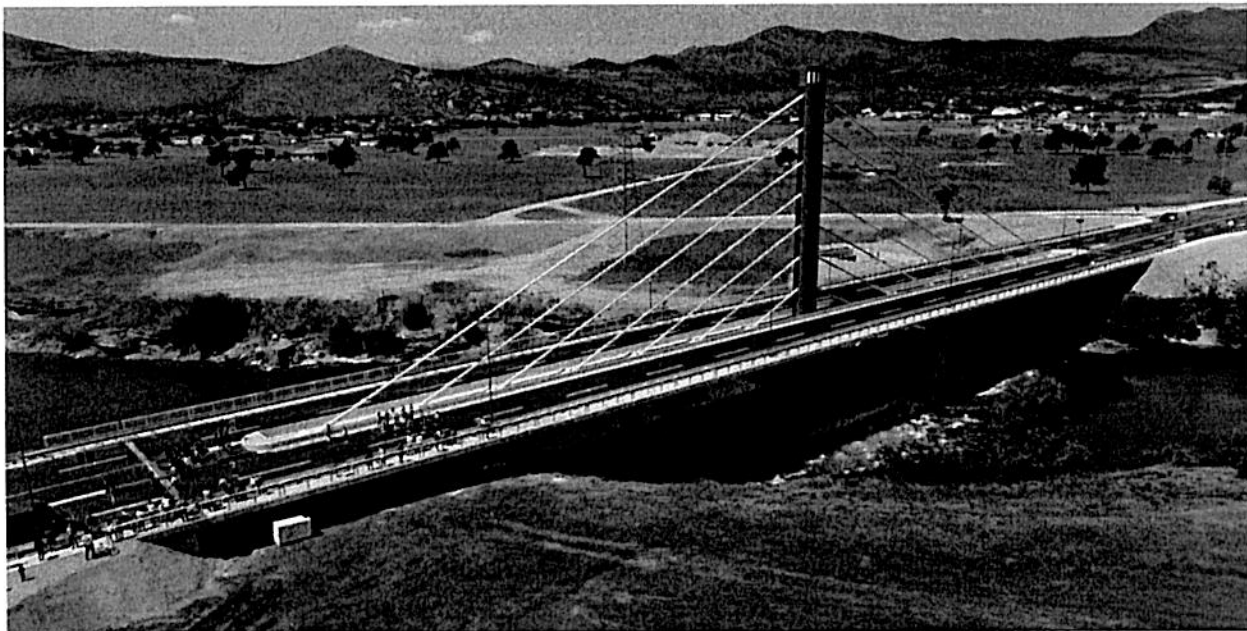
Slika br.1.11. Most “Luča” na jugozapadnoj obilaznici koja povezuje magistralne pravce koji povezuju Glavni grad sa Cetinjem i Petrovcem
